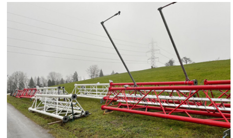
Bereit zum Aufrichten. Foto: Esther Weisskopf
