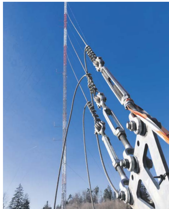
Der Mast wird von mehreren Drahtseilen gehalten.
