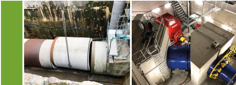
**Bild links: Einbau des letzten vorgefertigten Rohrs**
