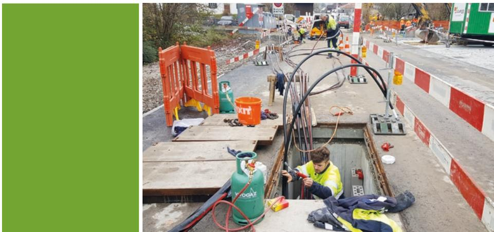
Mittelspannungs-Ringleitung in neue Trafostation Hallenbad einschlaufen.
