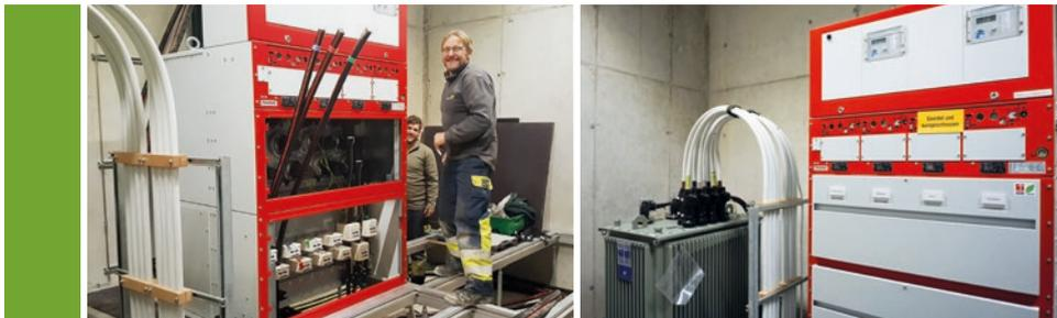
TS Hallenbad, Lieferung, Montage und Anschluss der elektrotechnischen Komponenten (Bild links).
