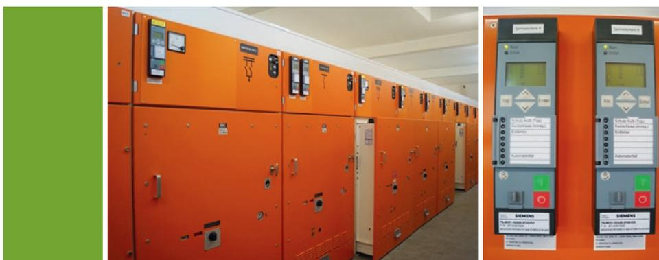
Mittelspannungsverteilanlage im Schalhaus Werkstrasse mit neuen Netzschutzkomponenten ausgerüstet (Bild links).
