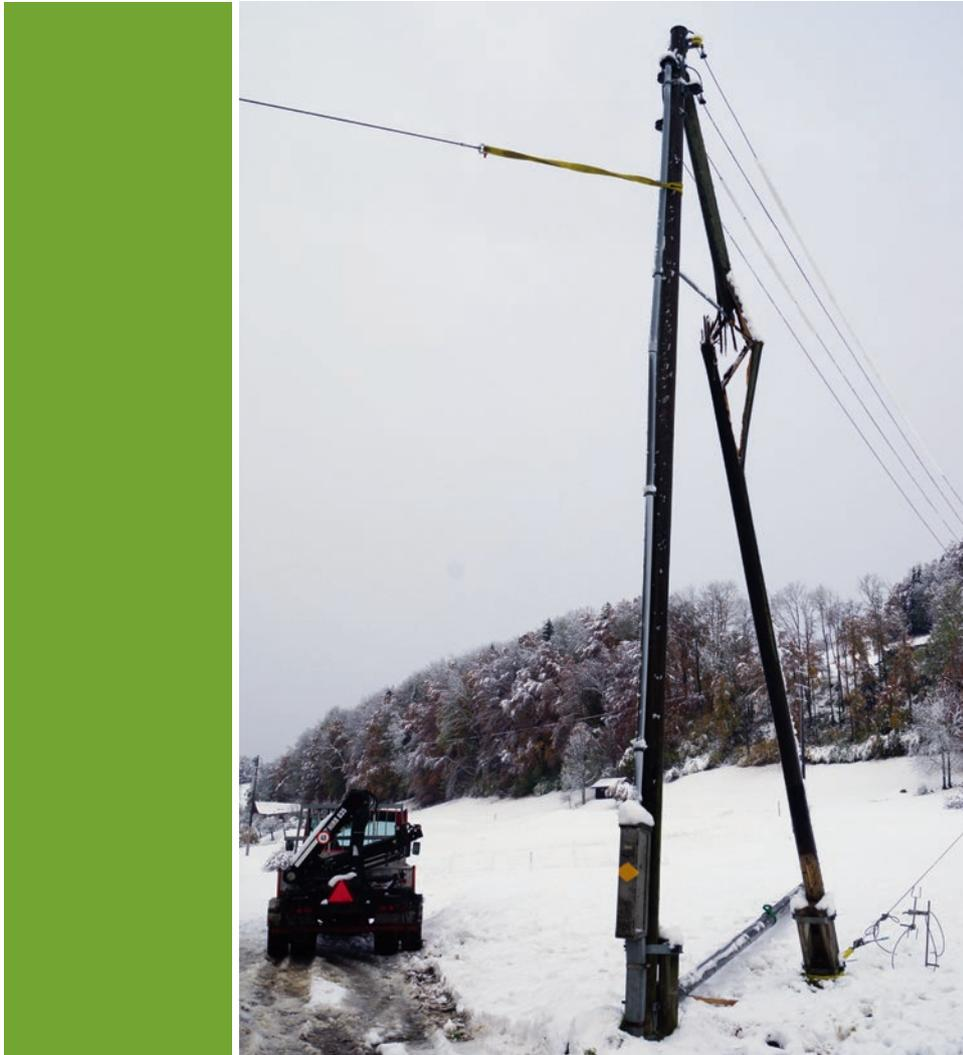
Ein durch Schneelast gebrochener Holzmast muss ersetzt werden.
