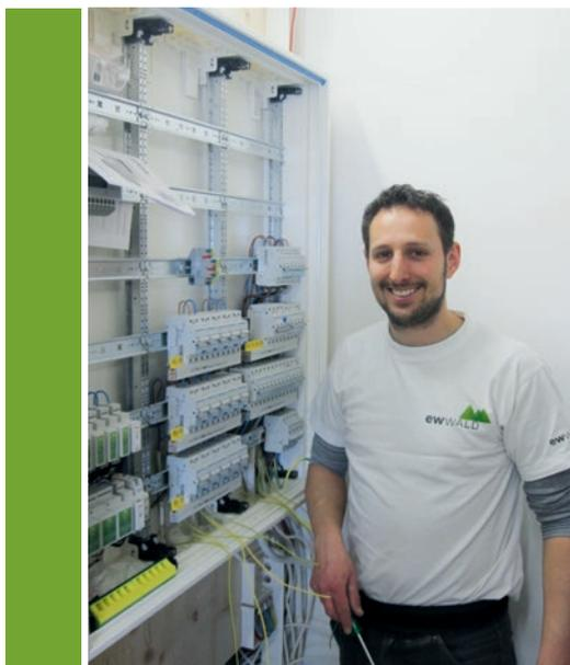
**Servicemonteur Mauro Puzzo bei der Verdrahtung einer Sicherungsverteilung mit digitalStrom-Komponenten (Bild links).**
