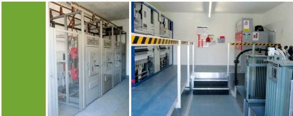
Trafostation mit offenem Sammelschienensystem vor der Sanierung (Bild links).
