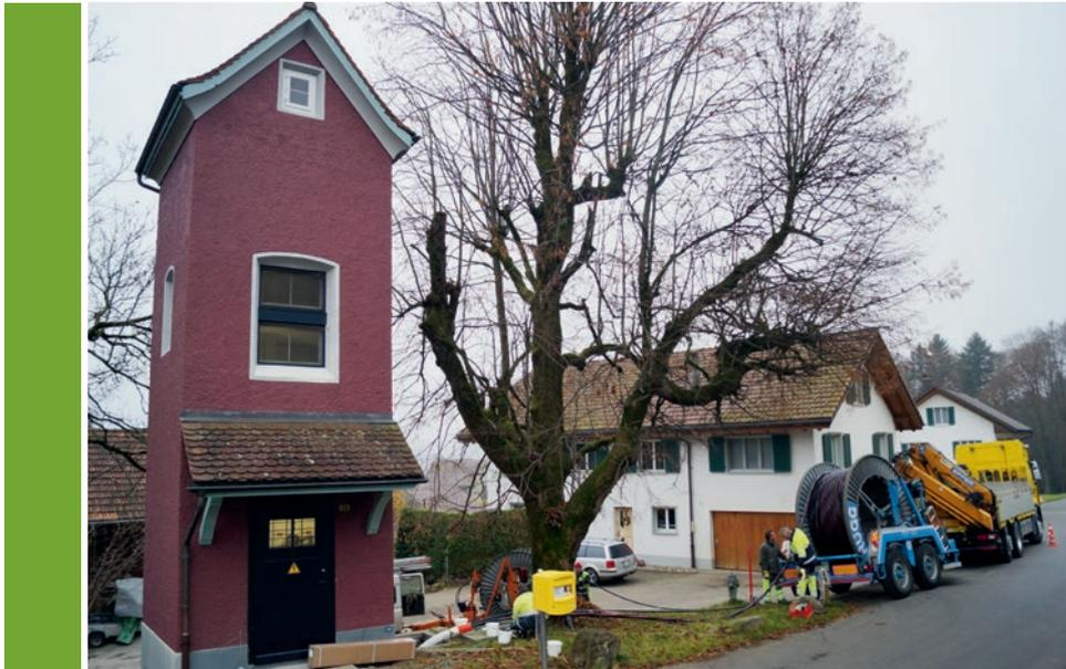
**Einzug von Mittelspannungskabel vor der Trafostation Hueb.**
