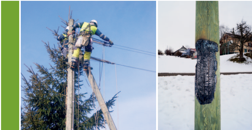
Unterhaltsarbeiten an Freileitungsanlagen (Bild links).
