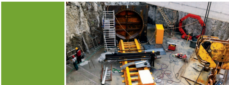
Bau der Kraftwerkzentrale Doppelpower in Mitlödi.
