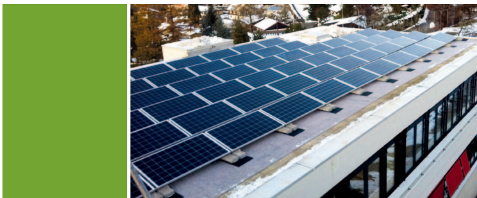
Eine der insgesamt drei Fotovoltaikanlagen auf dem Dach des Schulhauses Neuwies. Die drei Anlagen sind ein Gemeinschaftswerk der Gemeinde Wald und dem EW Wald und haben eine Gesamtleistung von 62 kWp und produzieren rund 55 000 kWh Strom pro Jahr.
