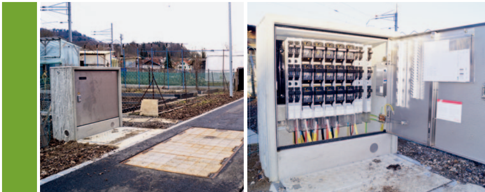
Neue Verteilkabine mit Kabelvorschacht an der Felsenkellerstrasse (Bild links) mit berührungssicherem Innenausbau (Bild rechts).
