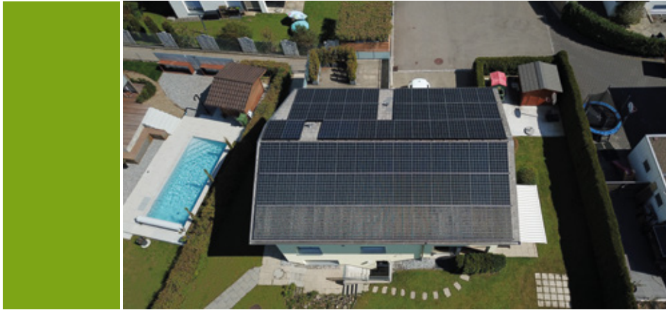
Aufdach-PV-Anlage, Ausrichtung West-Ost, mit gesamtflächiger Dachausnutzung
