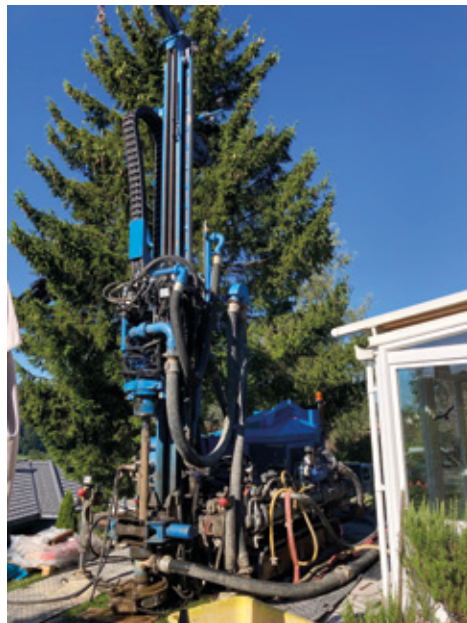
Aufwendige Erdsondenbohrung bei beschränkten Platzverhältnissen
