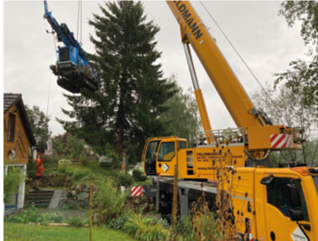
Krantransport der Erdsonden-bohrmaschine bei fehlender Zufahrtsmöglichkeit
