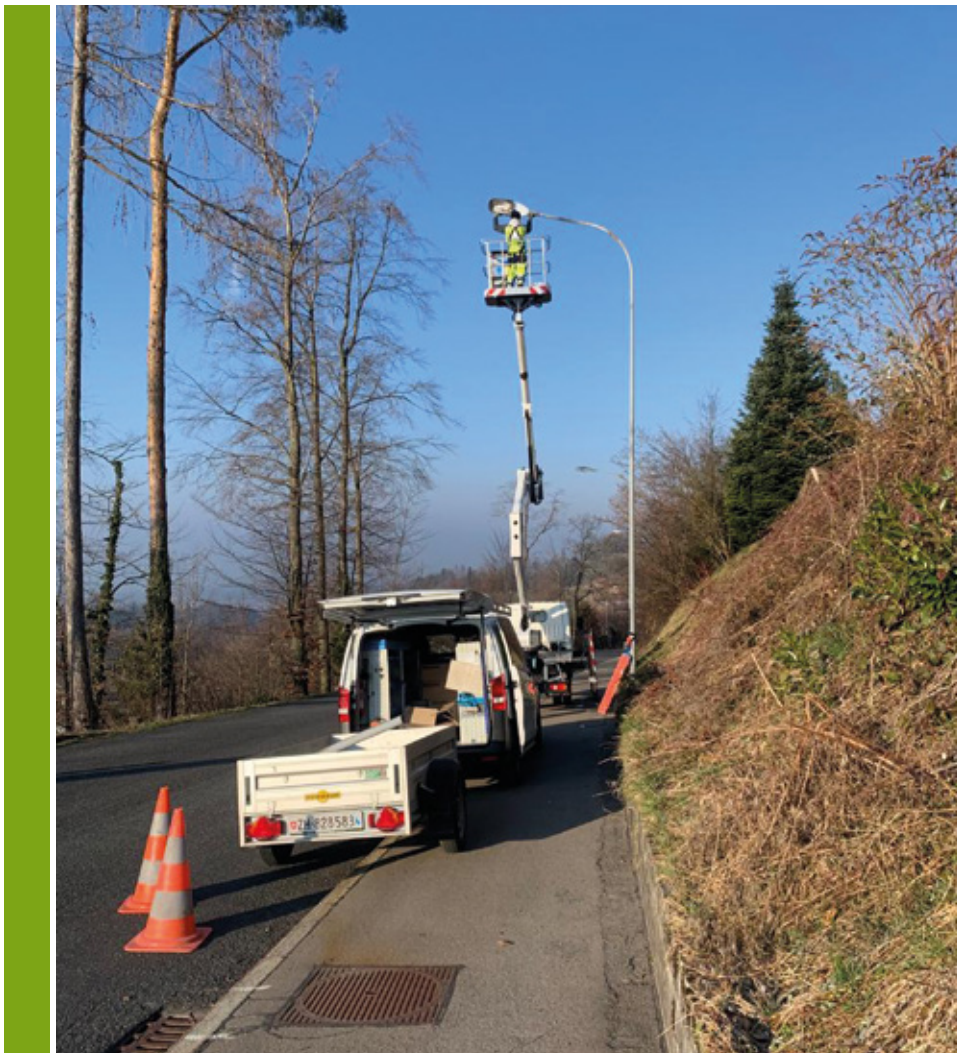
Ersetzen der alten Strassenleuchten durch neue intelligente und dynamisch gesteuerte LED-Leuchten
